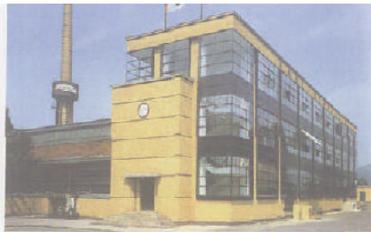
1 法古斯鞋厂是欧洲第一个完全采用钢筋混凝土结构和玻璃幕墙的建筑物，具有重要的建筑史学价值
