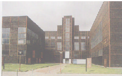
2 埃森关税联盟12号煤矿建筑由诺曼·福斯特设计改造成工业艺术展览馆
